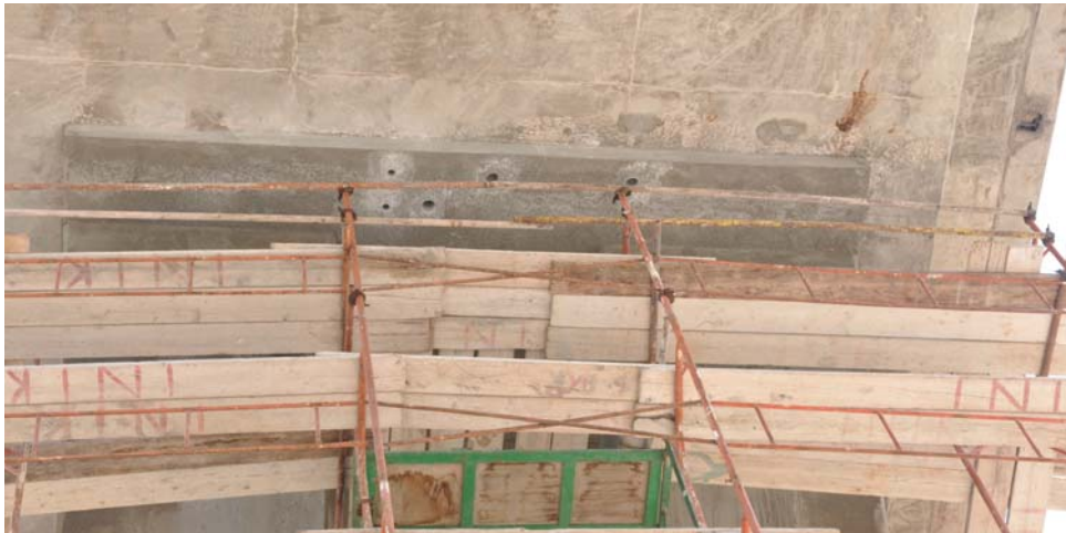
Σχ. 11 Όψη του εκτοξευόμενου σκυροδέμα στην βάση της διαδοκίδας (άνοψη). Διακρίνονται οι θέσεις όπου έγινε λήψη πυρήνων για τον έλεγχο αντοχής του σκυροδέματος.
