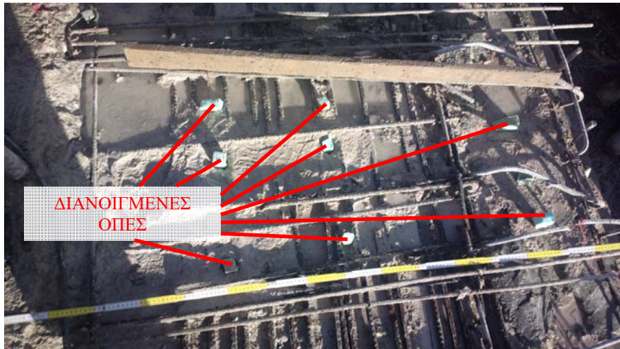
Σχ. 10 Διάνοιξη κατακόρυφων οπών στις διαδοκίδες για τοποθέτηση οπλισμών ενίσχυσης της διατμητικής αντοχής τους (διακρίνεται η προστασία τους).
