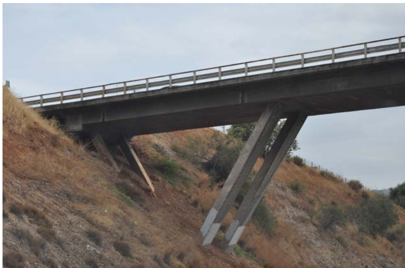
Σχ. 3 Άποψη μεσοβάθρου Μ1 Άνω Διάβασης Α296.
